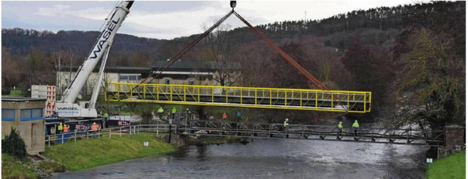
Die Sorgen waren am Ende unbegründet. Trotz einiger Windböen konnte die neue Stahlbrücke mühelos über die Rur gehoben werden.
